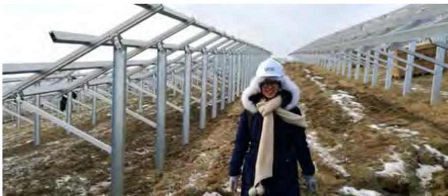
**Figura 4 – Modelo ejemplo de estructura de soporte de las placas al suelo ya implementada**
